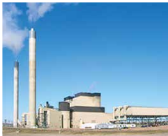
Wygen USA 110 MW
